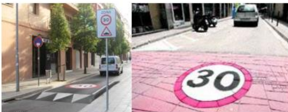
Fig. 30. Portes d'entrada a zona 30
