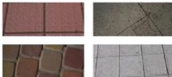
Fig. 17. Tipologia de paviments
